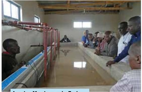
**Aus den Membranen im Tank wird sauberes Wasser gesaugt**
